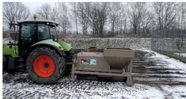
Einbau von rohrlosen Dränageschlitten bei einem Hockeyfeld in Bautzen 2018.
