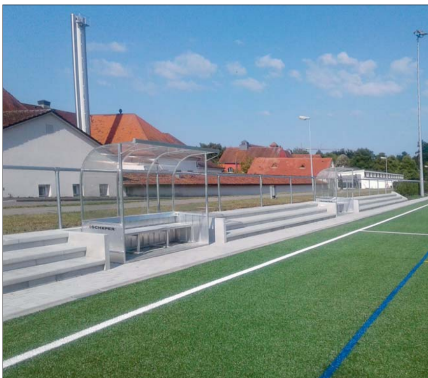
Bestehende Kunstrasenplätze, hier in Reichenau, werden vermutlich nicht geschlossen.
